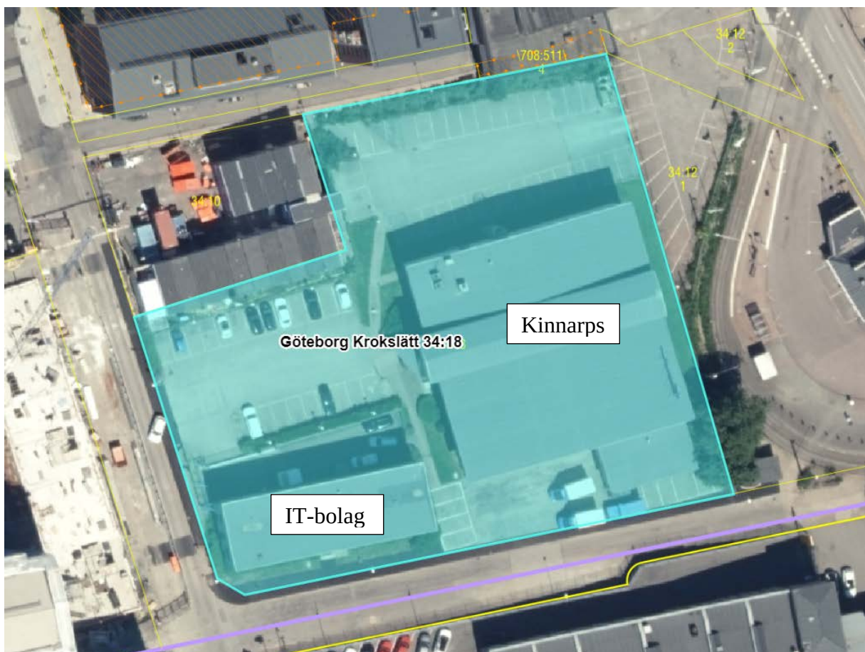
Figur 3. Krokslätt 34:18. Byggnaderna finns kvar och är i bruk. De avses att rivas inför nybyggnation.
